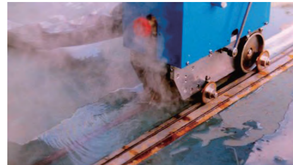
レール状のガイドに沿って自動走行する加熱台車
