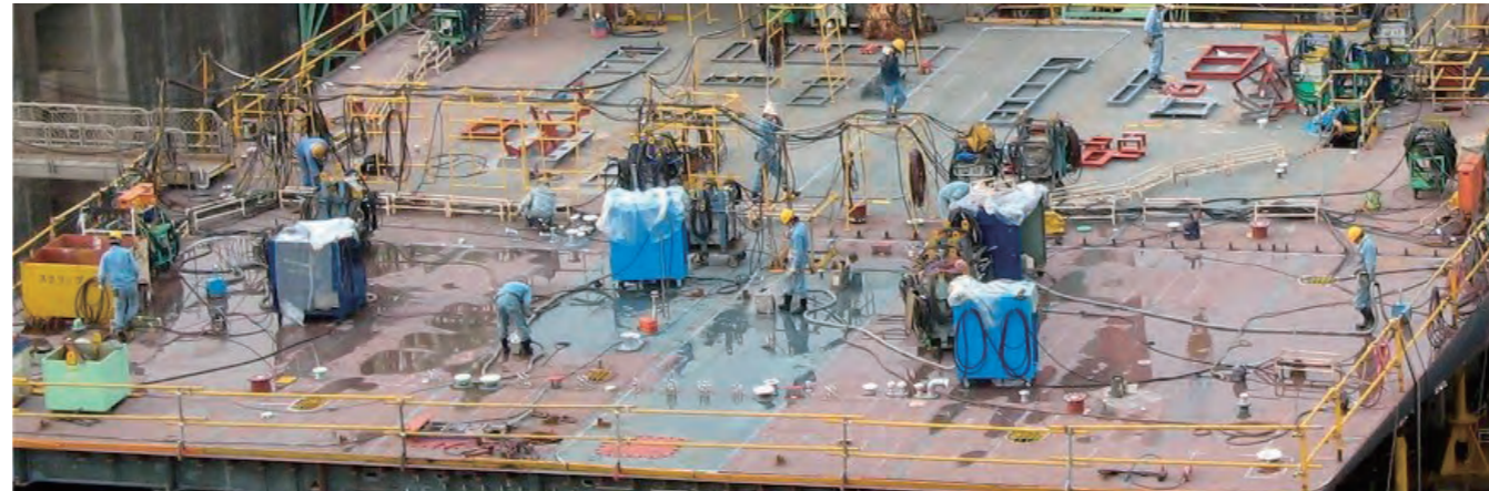
建造中の艦艇での作業風景(溶接歪取用高周波誘導加熱装置)
